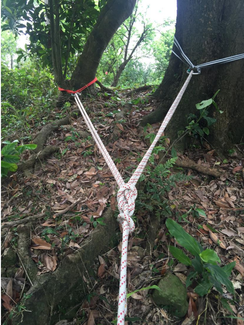
架設二處固定點
